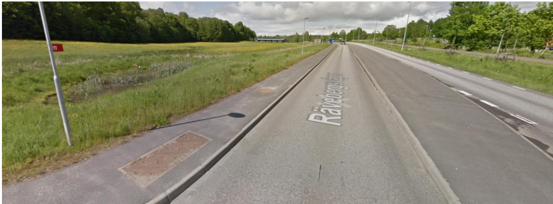
Figur 4 Bilden visar Råvebergsvägen som är ett exempel på en hårt belastad yta. Till vänster i bilden syns en damm längs med vägen, byggd för att rena dagvatten. Dammen hanterar idag inte dagvattnet från vägen, men denna typ av lösningar uppfyller kravet på rening för hårt belastade ytor.
