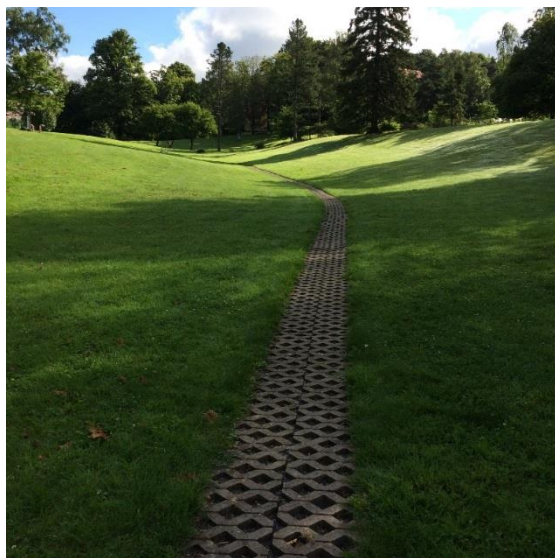
Figur 5 Bilden visar en multifunktionell yta för dagvatten, skyfall och rekreation. Dagvattnet infiltrerar i den permeabla beläggningen men vid skyfall kan större volymer samlas i svackan förutsatt att det finns en dämning. Till vardags nyttjas dock området för rekreation.
